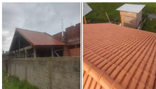
Foto 06: CRAS de Chaves com 60% da obra concluída.
