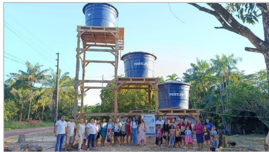
Foto 34: Cisterna implantada em São Domingos do Capim. Foto Relatório Mensal SEATER.
